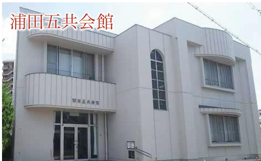
昨年外壁工事をを行い、きれいになった会館
